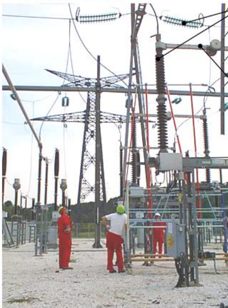
Sectionneur 63 kV
